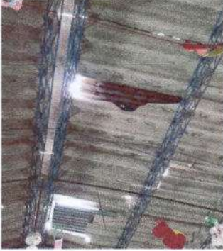
Foto1: Sustitución de lámina, por lámina troquelada de aluzinc calibre 26 módulos 1,2,3,4 y 5
