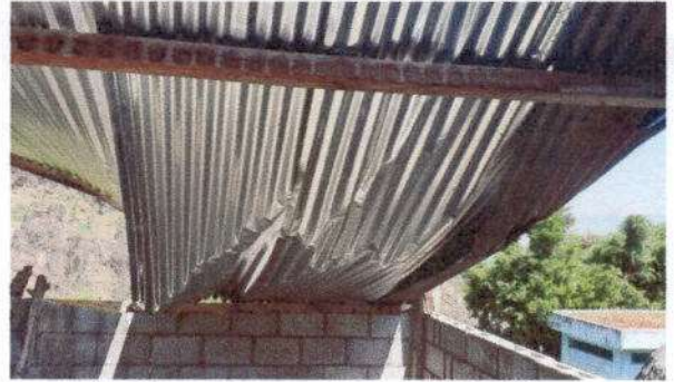
Foto 2: Mantenimiento a estructura de soporte metal.
