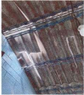
Foto1: Sustitución de lámina, por lámina troquelada de aluzinc calibre 26 módulos 1,2,3,4 y 5
