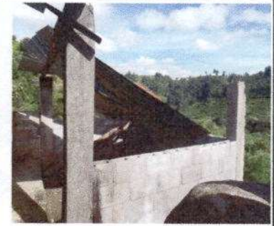
Foto 6: Sustitución de deposito de agua y muro de contención
