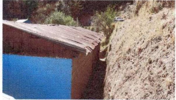
Foto 4: Sustitución de lámina, por lámina troquelada de aluzinc calibre 26 módulo 3.
